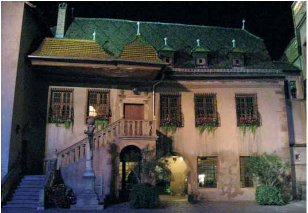
Nach dem neuen Beleuchtungskonzept bestrahltes Gebäude in Colmar
